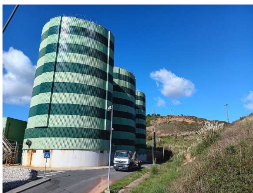
CDA da Abrunheira – vista dos biodigestores.
