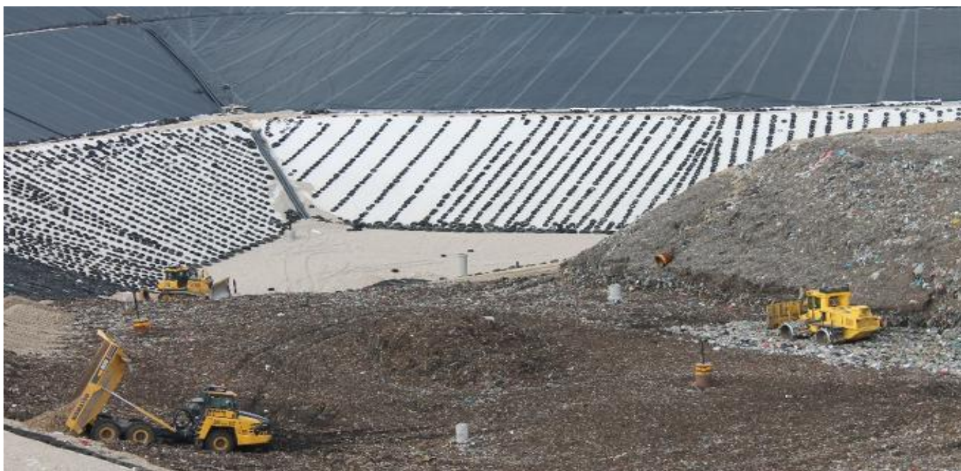
Figura 17 Aterro Sanitário da Tratolixo em exploração (Ecoparque da Abrunheira)
